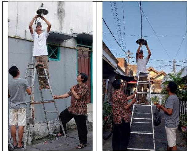
**Gambar 2.** Pemasangan fitting lampu dengan sensor eksternal
