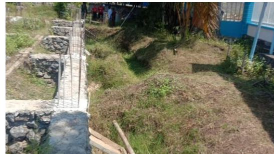
Gambar 5. Tampak 2 kondisi eksisting
