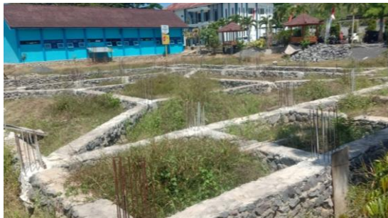
Gambar 4. Tampak 1 kondisi eksisting
