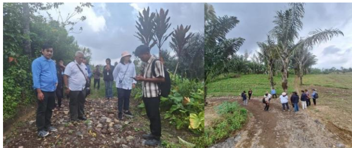
Gambar 13. Survei ke Lokasi Pembangunan Perkerasan Jalan (Telford)
