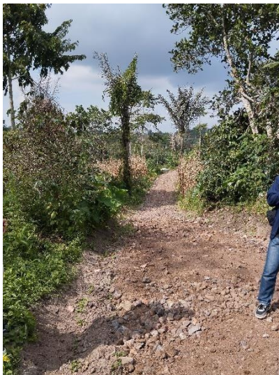
Gambar 3. Kondisi Pembangunan Jalan Telford Desa Sihemun Sumber : Dokumentasi Lapangan
