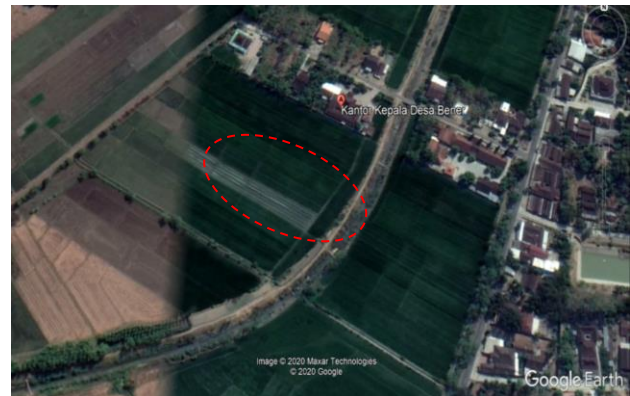
Gambar 2. Lokasi Pipa Pralon (Talang) Irigasi DI Ngarum
