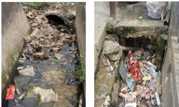
Gambar 5. Kondisi Saluran Drainase (Sumber: Dokumentasi Pribadi, 25 Februari 2021)
