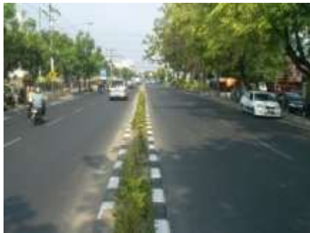
Gambar 24. Kondisi Jalan Adi Sucipto pada Sisi Timur Gerbang Makhuto
