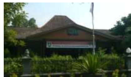
Gambar 43. Bangunan Kantor PDAM Surakarta
