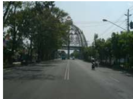
Gambar 25. Kondisi Jalan Adi Sucipto pada Sisi Timur Gerbang Makhuto
