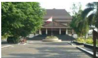
Gambar 42. Bangunan DPRD Kota Surakarta
