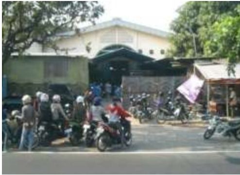
Gambar 32. Bangunan Industri di Jalan Adi Sucipto
