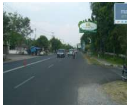
Gambar 27. Kondisi Jalan Adi Sucipto pada Sisi Barat Gerbang Makhuto
