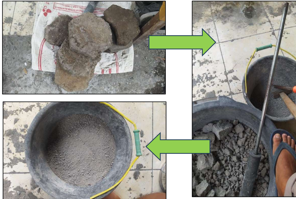
Gambar 9. Proses pembuatan paving baru dari recycle paving lama
