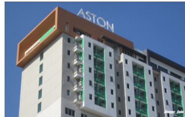
Gambar 29 Detail Bagian Atas Bangunan
