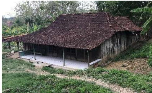
Gambar 17. Bangunan bentuk Paris/Limasan
