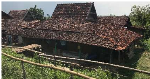
Gambar 18. Bangunan bentuk Wedhok / Beluk Lulang
