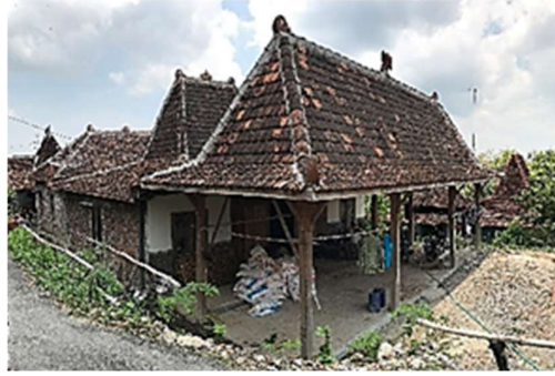
Gambar 19. Bangunan bentuk Sinom
