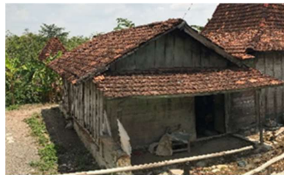
Gambar 20. Bangunan bentuk Rongpyak
