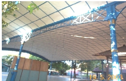
Gambar 6. Bentuk Plafon Lengkung/ dome pada Bangsal Sewayana
