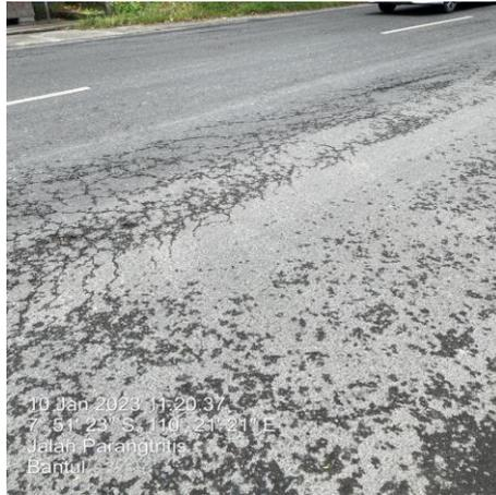
**Gambar 7.** Contoh kerusakan jenis retak buaya (*alligator cracking*)
