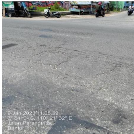
**Gambar 8.** Contoh kerusakan jenis retak blok (*block cracking*)
