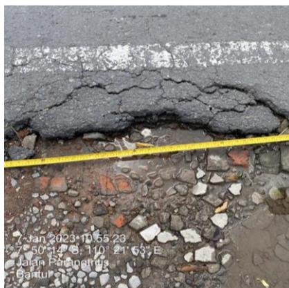
**Gambar 9.** Contoh kerusakan jenis retak pinggir (*edge cracking*)
