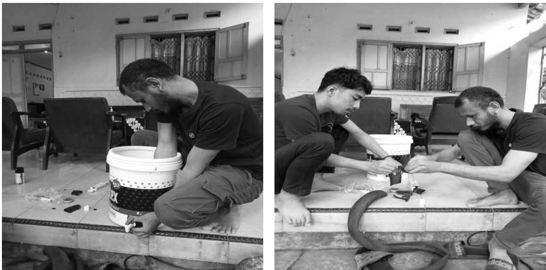
Gambar 3. Pemasangan Mata Kran Di Ember
