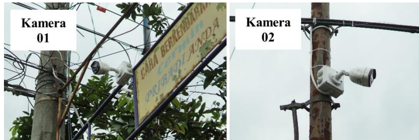
Gambar 13. Titik pemasangan kamera CCTV 01 dan 02
