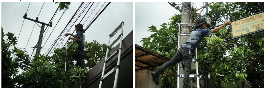
Gambar 7. Pemasangan CCTV di titik yang telah ditentukan
