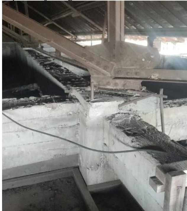
Gambar 1. Pengamatan Elemen Struktur Bangunan
