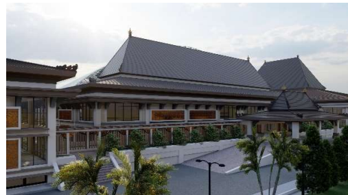
Gambar 11. Eksterior Bangunan Sumber : penulis, 2023
