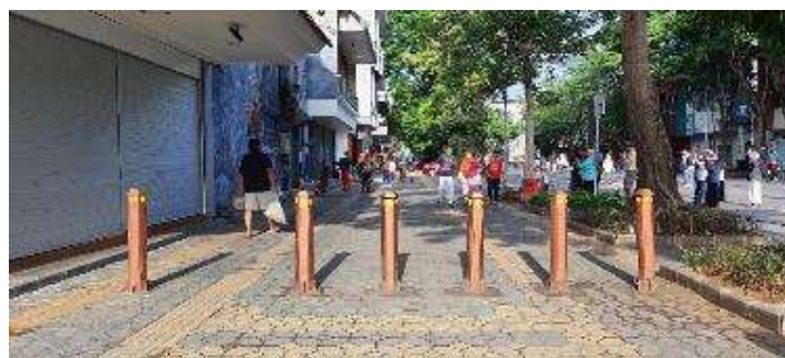
Gambar 7. Pemasangan bolar untuk menghalangi kendaraan bermotor yang akan lewat di jalur pedestrian Sumber: Observasi Lapangan (2023)
