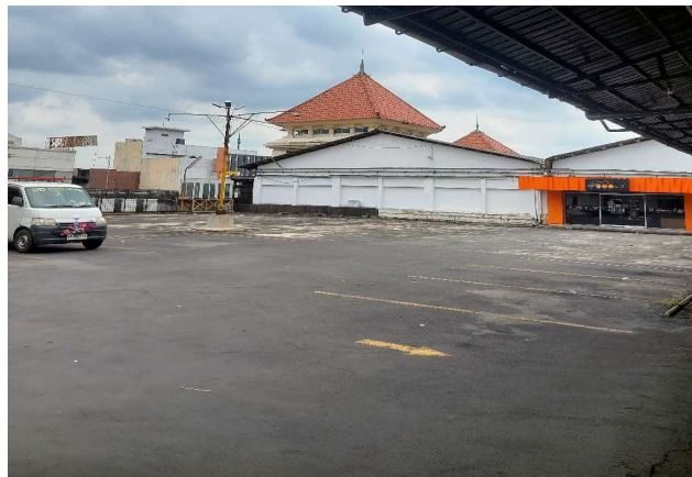
Gambar 7. Kondisi Gedung Parkir Matahari Singosaren (Sumber : Data Pribadi, Autocad, 2025)
