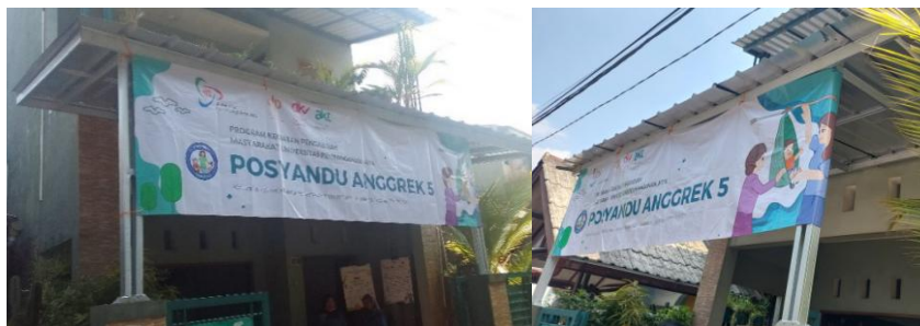
Gambar 7. Hasil pembuatan fasilitas kanopi pelindung
