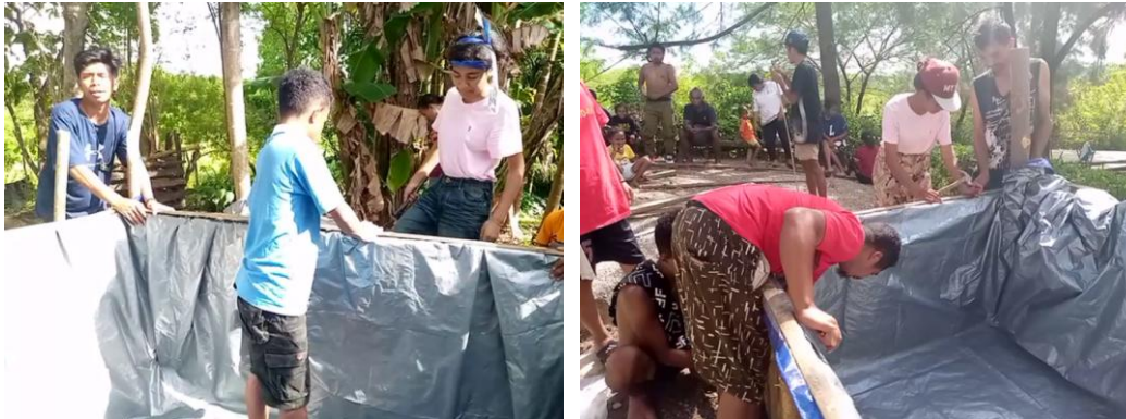
Gambar 3. Pemasangan terpal pada kolam sistem aquaponik
