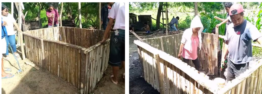
Gambar 2. Proses pembuatan kolam terpal dari bahan lokal
