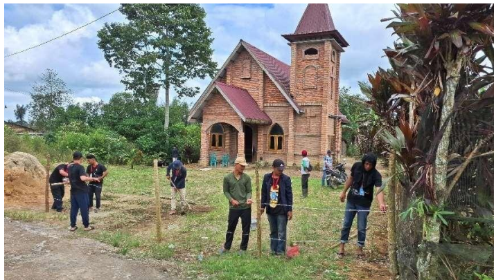
Gambar 8. Pembuatan Pagar Gereja Katolik (Sumber: Dokumentasi Pribadi, 2024)
