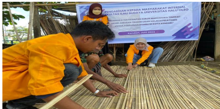
Gambar 6: Mahasiswa Menyisipkan Belahan Bambu Secara Teratur
