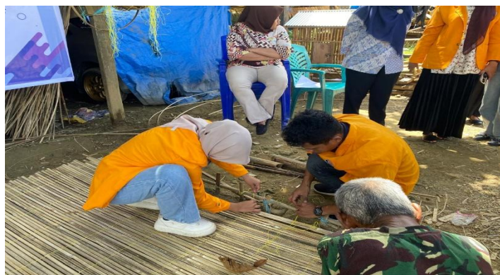
Gambar 7: Mahasiswa Menyisipkan Belahan Bambu Penyangga dan Mengikatnya
