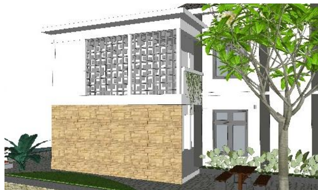
Gambar. 7 Penerapan roster dan material bebatuan pada gedung tambahan
