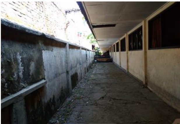
Gambar 4. Foto kondisi tempat parkir sepeda
