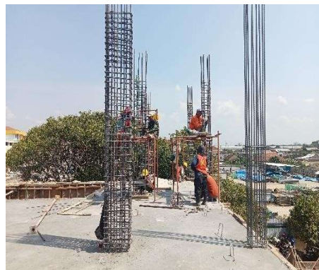
Gambar 1. Pekerjaan pembesian kolom
