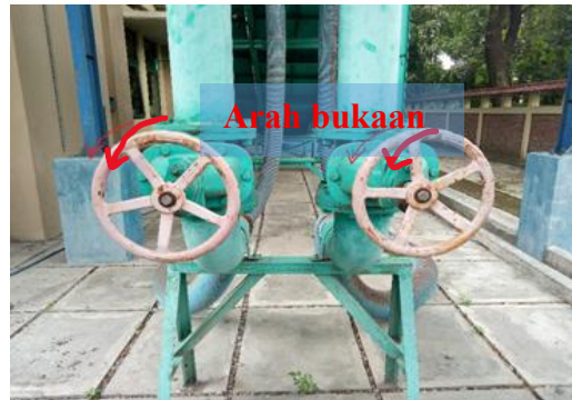
Gambar 3. Bukaan Pipa Pengaturan Debit
