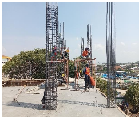
Gambar 1. Pekerjaan pembesian kolom
