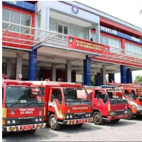
Gambar 1. Kantor atau Pos Dinas Pemadam Kebakaran Kota Surakarta.
