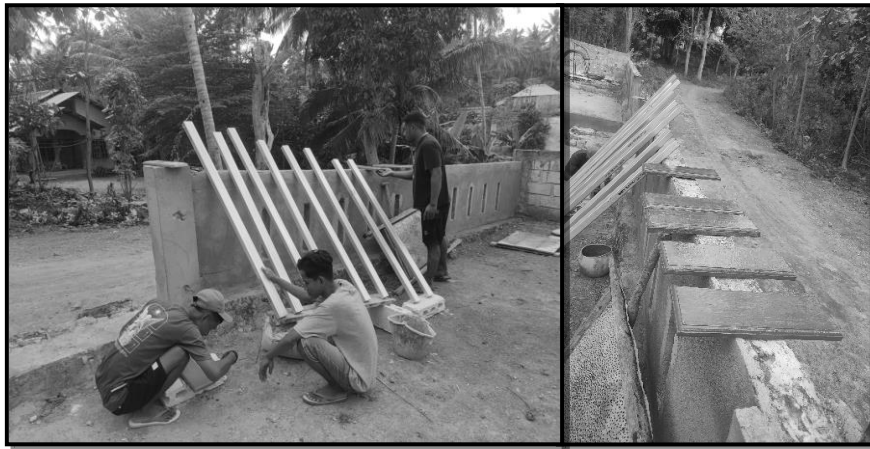
Gambar 2. Proses Pembuatan dan Pengecatan Plang Nama Jalan
