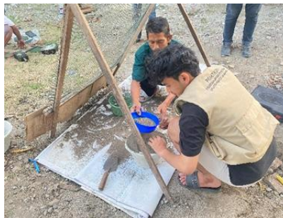
Gambar 3. Mempersiapkan pasir untuk dicampurkan oleh bahan lain
